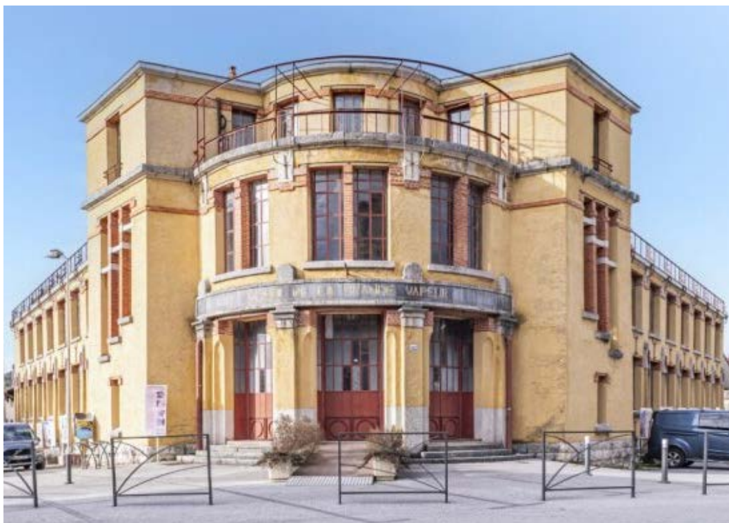
Usine de la Grande Vapeur à Oyonnax © Fondation du patrimoine_MyPhotoAgency_Jeremy Penel
