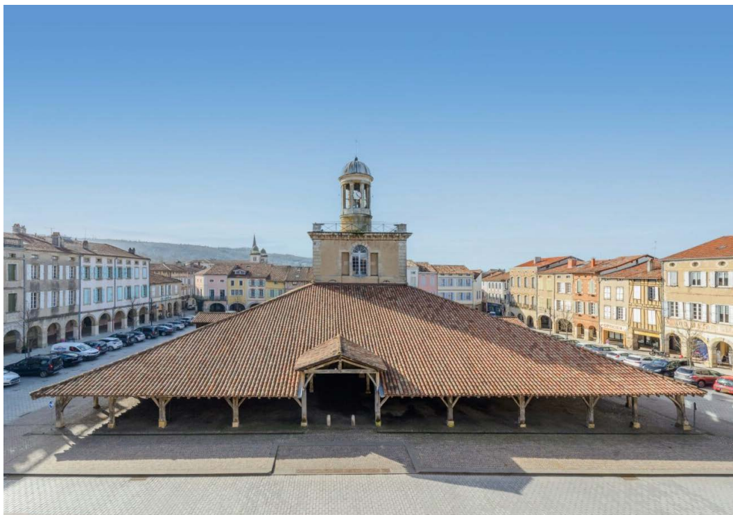
Halle et beffroi de Revel © Fondation du patrimoine_MyPhotoAgency_Laetitia Riehl
