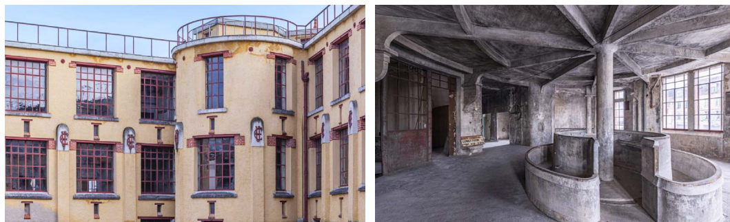
Usine de la Grande Vapeur à Oyonnax © Fondation du patrimoine_MyPhotoAgency_Jeremy Penel
