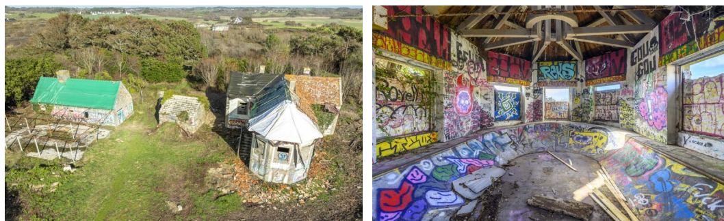
Ancien sémaphore du Pouldu à Guidel © Fondation du patrimoine_MyPhotoAgency_Jean-Yves Gautier
