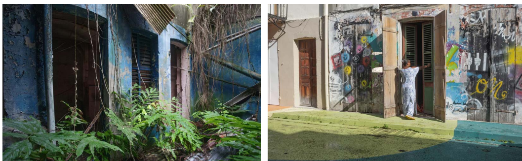
Immeuble du 8, rue Garnier-Pagès à Fort-de-France © Fondation du patrimoine_MyPhotoAgency_Daniel Brieu
