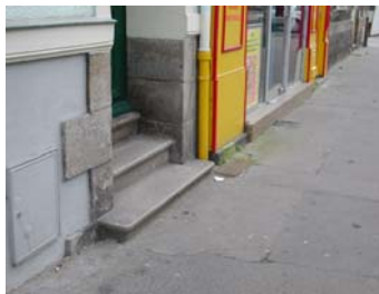
7 : Différents accès aux bâtiments
