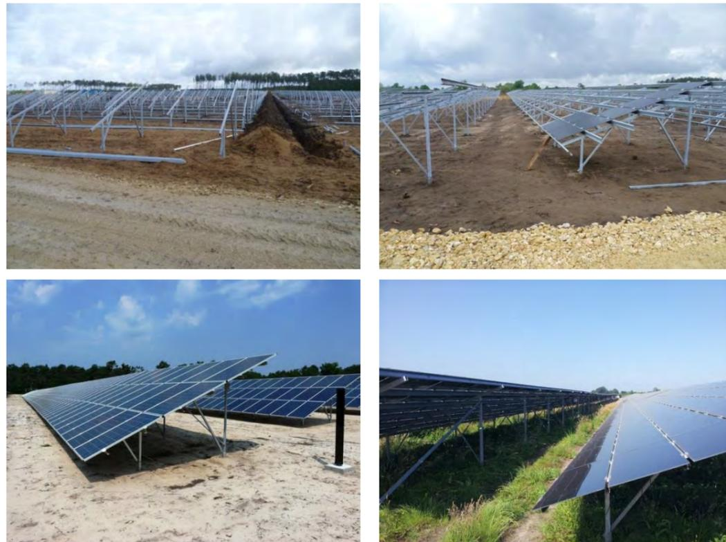
Photo 39 : Exemples de structures porteuses
