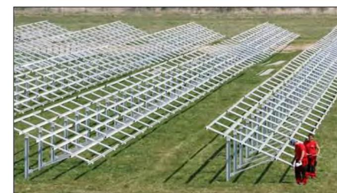
Photo 38 : Exemple de châssis fixes orientés sud
