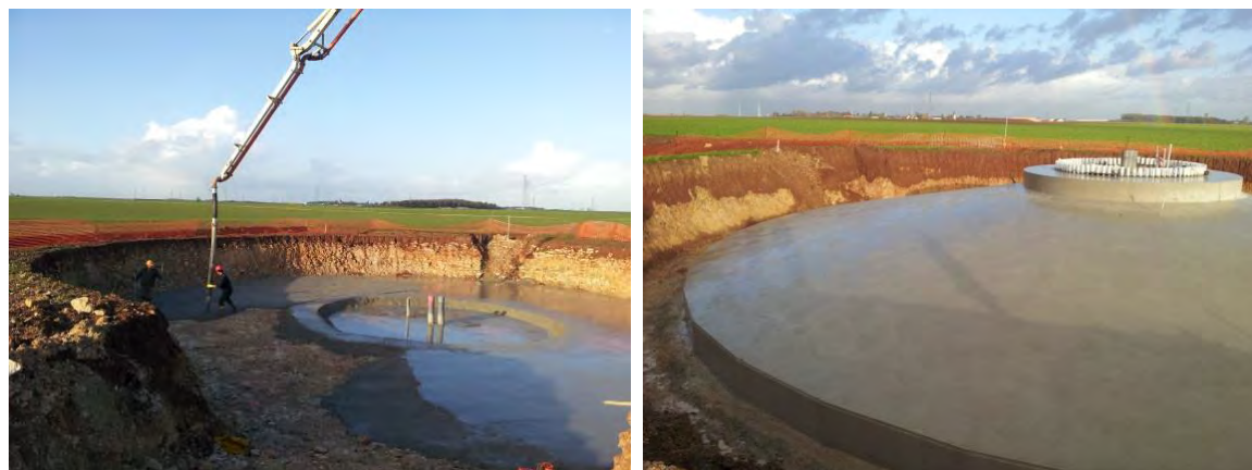
Chantier éolien – Novembre 2013
