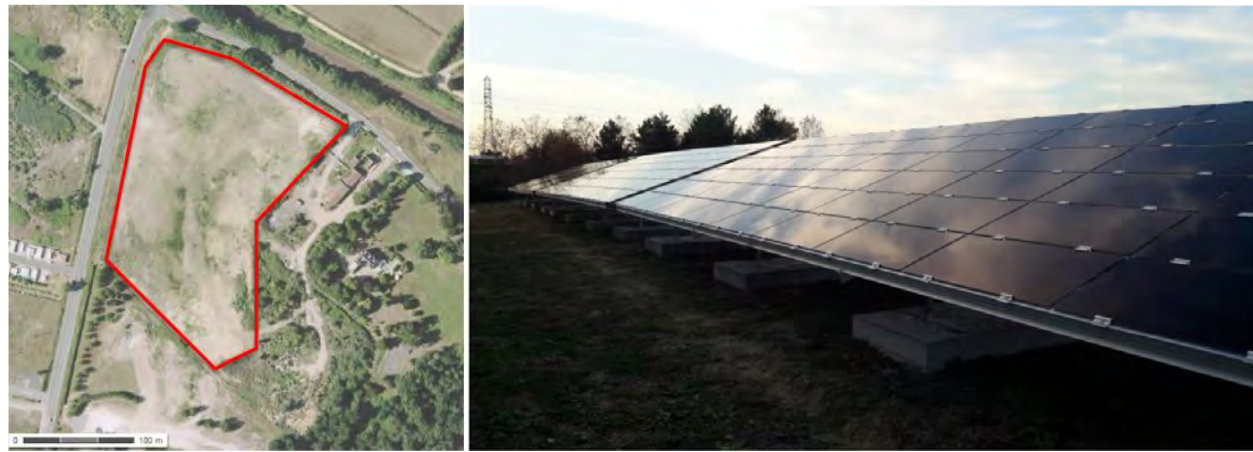
Photo 5 : Localisation et vue de la centrale photovoltaïque de Saint-Loubès (33) développée par JPee
