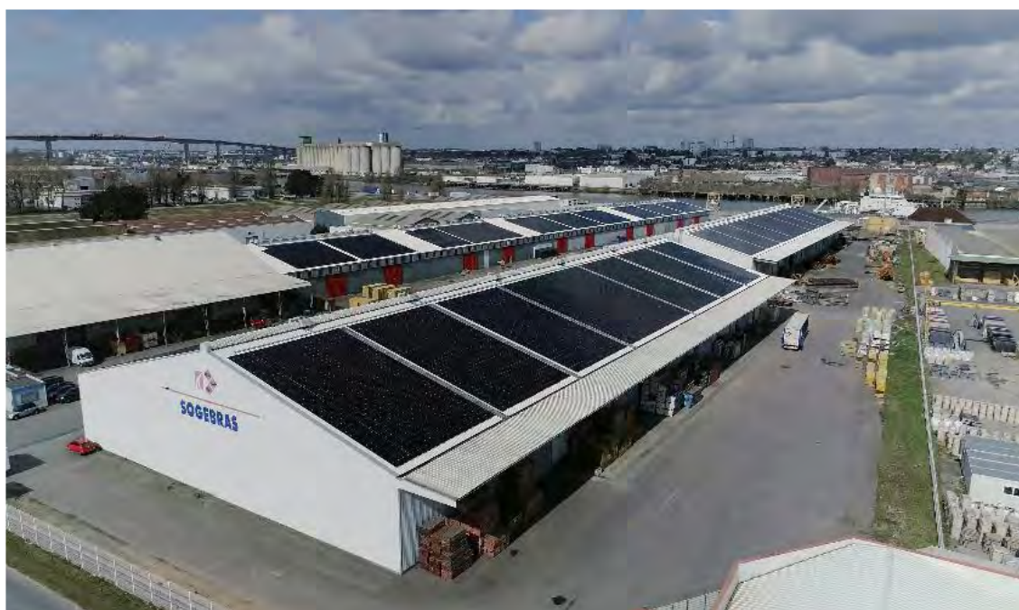
Photo 2 : photovoltaïque en toiture de Cheviré
