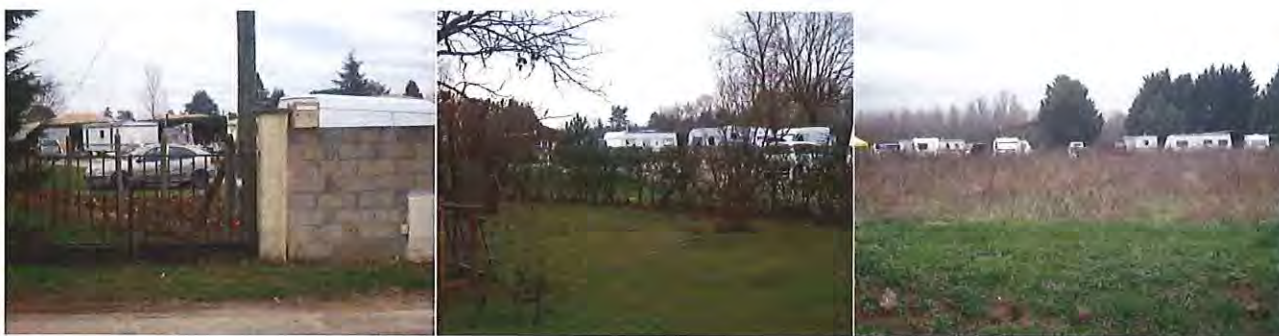
Lamonzie-Saint-Martin : surpopulation, absence de réseaux d'alimentation et d'évacuation. Actuellement de nombreuses constructions continuent d'être édifiées.
